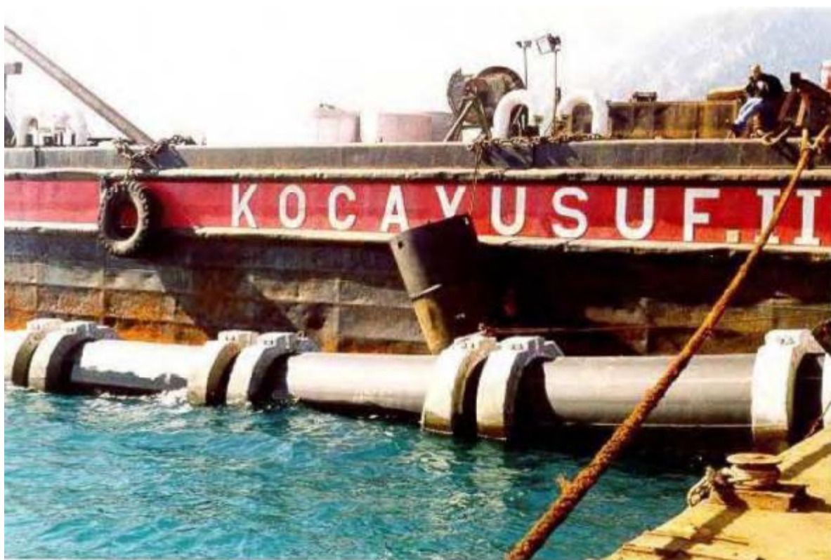
Рисунок 2 – Бетонные пригрузки крепятся к трубопроводу
