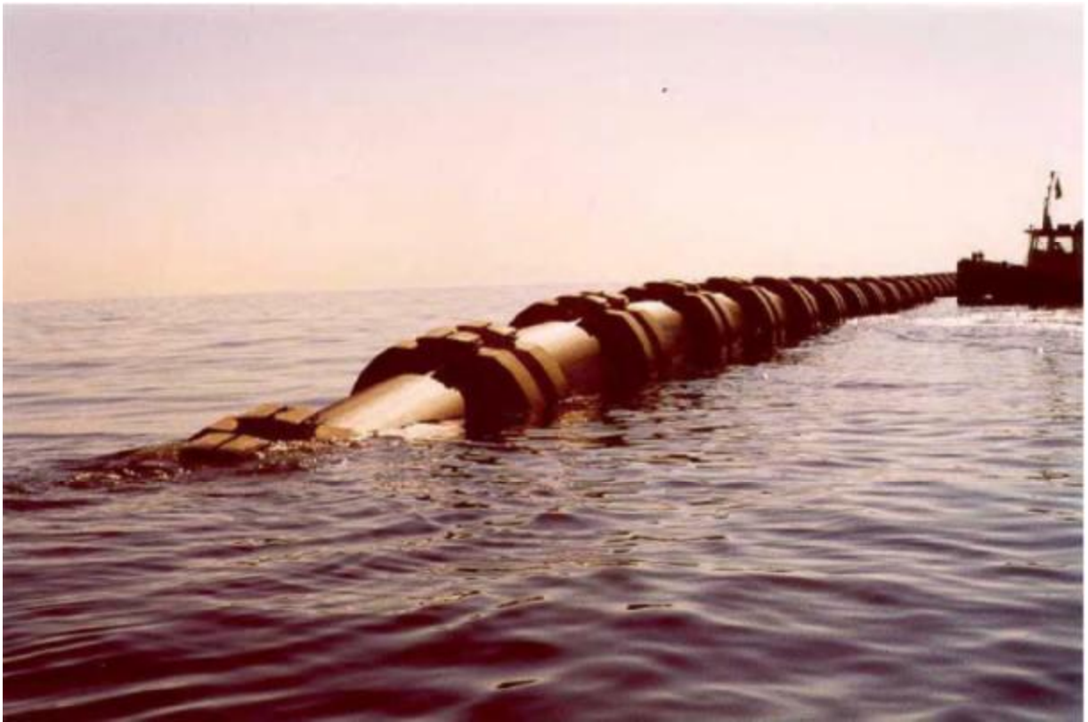
Рисунок 5 – Процесс погружения уже начался
