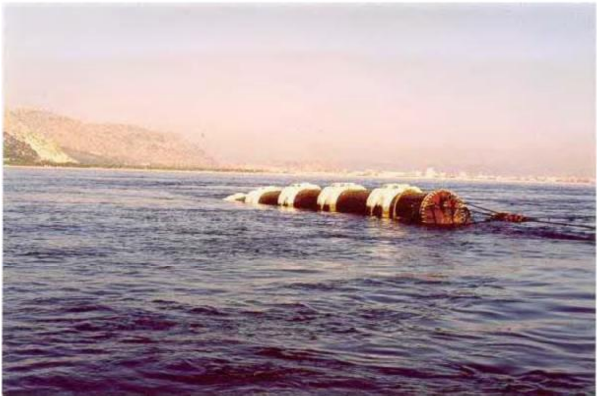
Рисунок 6 – Незадолго до того, как конец трубопровода покинет поверхность и погрузится
